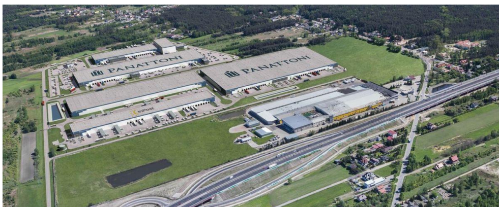
Zdjęcie 3 Obiekty logistyczno-przemysłowe istniejące i projektowane w miejscowości Ciemne
