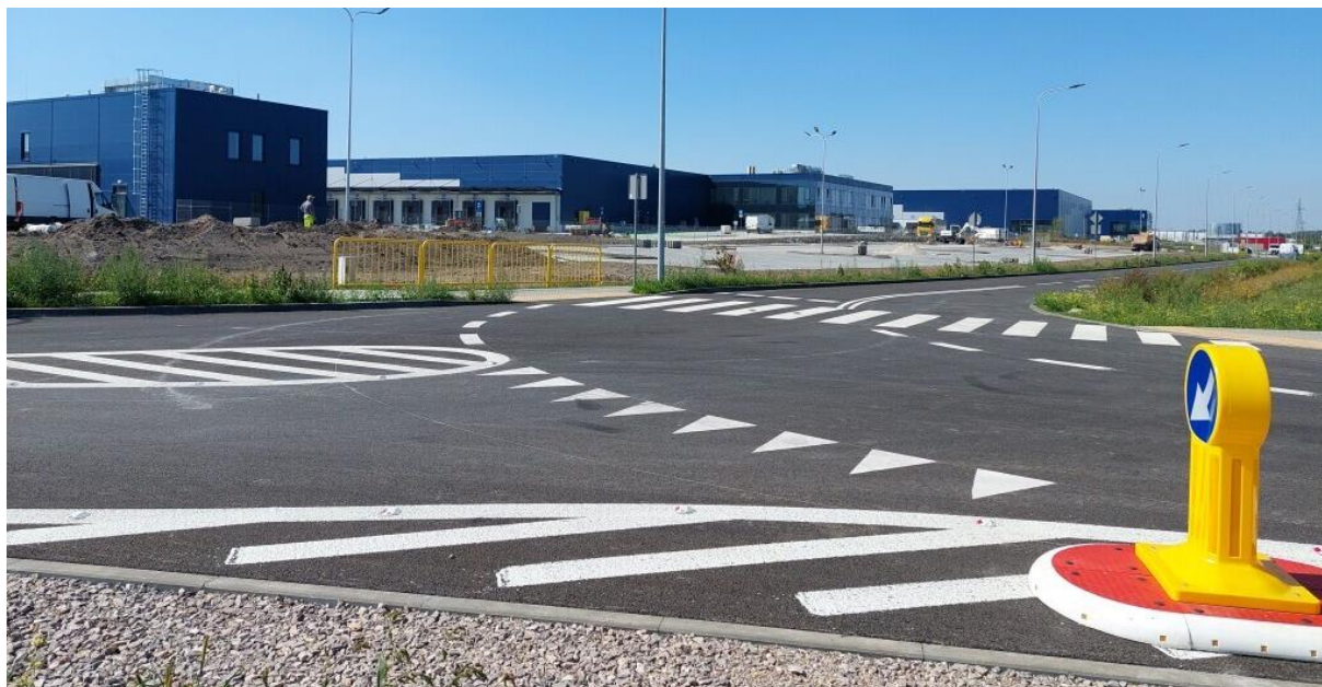
Końcówka ulicy Logistycznej z oddanym do użytku w 2023 r. dojazdem do obiektów Poczty Polskiej
