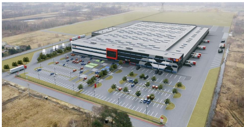
Zdjęcie 4 Obiekt magazynowo-biurowy w miejscowości Dybów Kolonia
