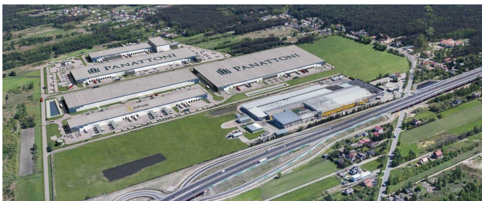
Zdjęcie 3 Obiekty logistyczno-przemysłowe istniejące i projektowane w miejscowości Ciemne
